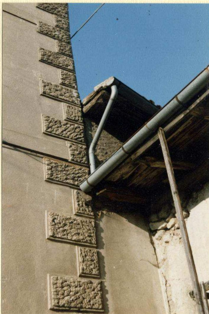
Le decorazioni di facciata rilevate con più frequenza sono quelle ottenute con la tecnica del bugnato. Attraverso la lavorazione di determinate fasce di intonaco messo in rilievo con vari sistemi vengono evidenziati spigoli di edifici e marcapiani.
