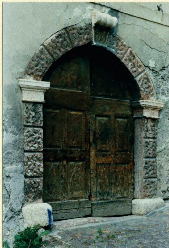
Porta in legno ad una o due ante composta da un telaio con specchiatura. Le specchiature, spesso, sono lavorate dando loro una certa sagomatura di rilievo.
