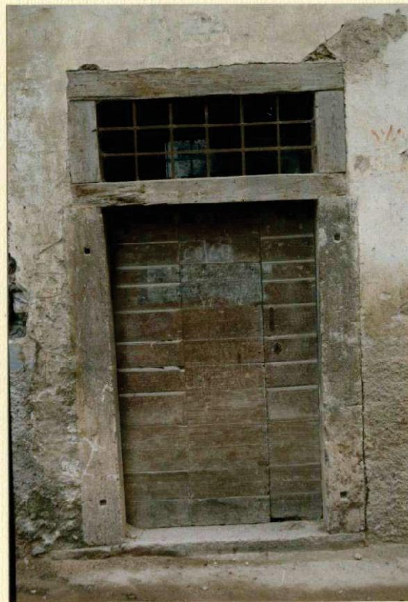
In questo tipo di accesso si può notare l'architrave costituita da un travetto in legno squadrato di dimensioni variabili a seconda della luce del foro. L'architrave di legno poggia su stipiti che possono essere sia in muratura che in pietra.
