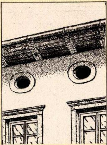
Aperture di forma ellittica poste nei sottotetti in corrispondenza verticale delle aperture sottostanti. Dai contorni in pietra o in intonaco liscio o in rilievo servono esclusivamente per dare aria e luce alle soffitte. Costruiti in questa particolare forma prettamente a scopo estetico non sono molto frequenti e comunque riscontrati in quegli edifici di particolare rilievo storico-architettonico.
